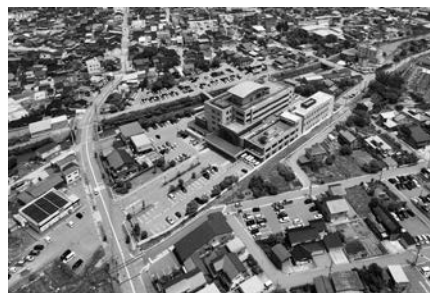
公立つるぎ病院(令和5年)
